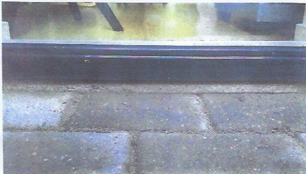
Under døre og vinduer er der en skumgummi lignende fuge, som ved konstant fugt vil gå i opløsning og der vil derefter, være fri adgang for fugtskader på gulve og vægge.
